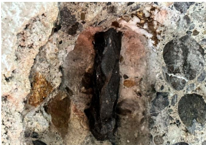
Abb. 2: Spitzsondage an Unterzug (KG 0)
