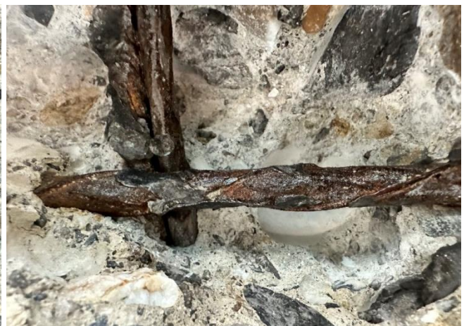
Abb. 3: Spitzsondage an Deckenunterseite (KG 2)
